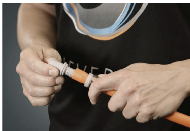
Introducerea fittingului
