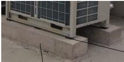
Beton de baza
